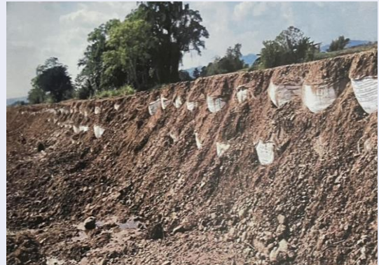
5. โครงการวางถุงบิ๊กแบ็คป้องกันตลิ่งพัง บ้านดอนไชยป่าแซม หมู่ที่ 14 ต.ออย อ.ปง จ.พะเยา
