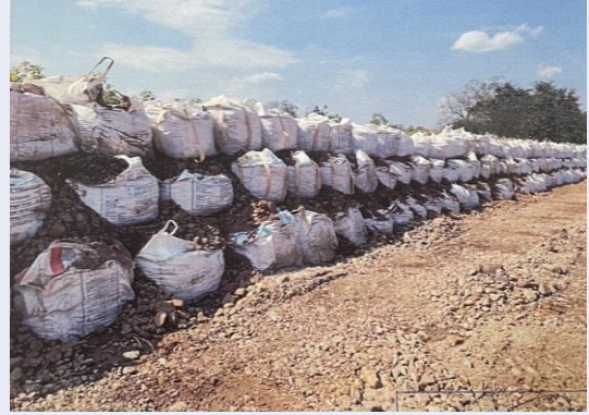
4. โครงการวางถุงบิ๊กแบ็คป้องกันตลิ่งพัง บ้านหลวง หมู่ที่ 6 ต.ออย อ.ปง จ.พะเยา
