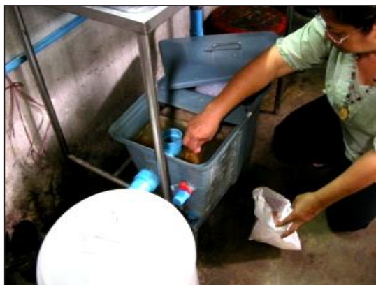
รูปที่ ๓.๑๑ การดักไขมันออกจากถังดักไขมัน
